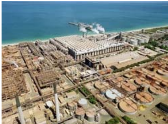
Alcoa - Kwinana Refinery
